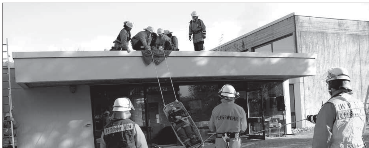
Liegend geborgen werden muss vom Dach der Festhalle Scheer einer der beiden Arbeiter, der sich bei der Explosion einer Gasflasche schwerste Verbrennungen hinzugezogen hat. Foto: privat
